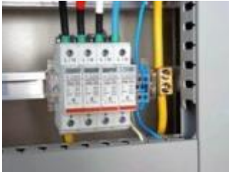
Überspannungsschutz (innerer Blitzschutz)
